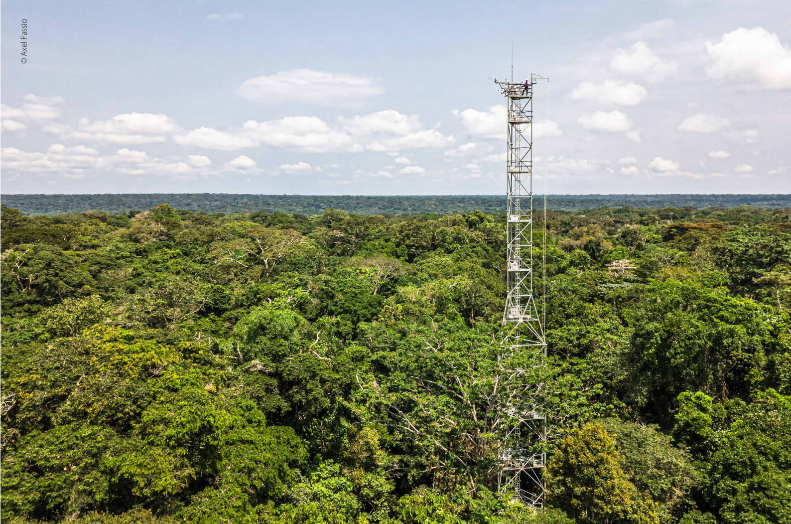
▼ La torre Congoflux instalada en la reserva de biosfera de Yangambi (RDC) recoge datos para poder entender mejor los mecanismos de captación de carbono.
