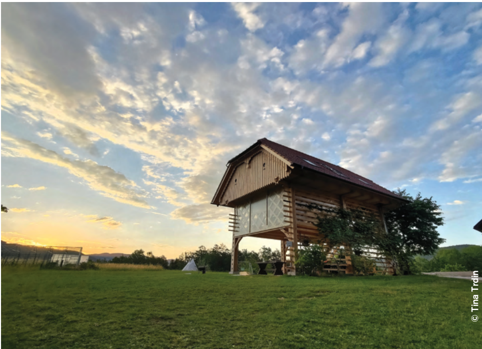
△ Construction en bois typiquement slovène appelée topljar.
